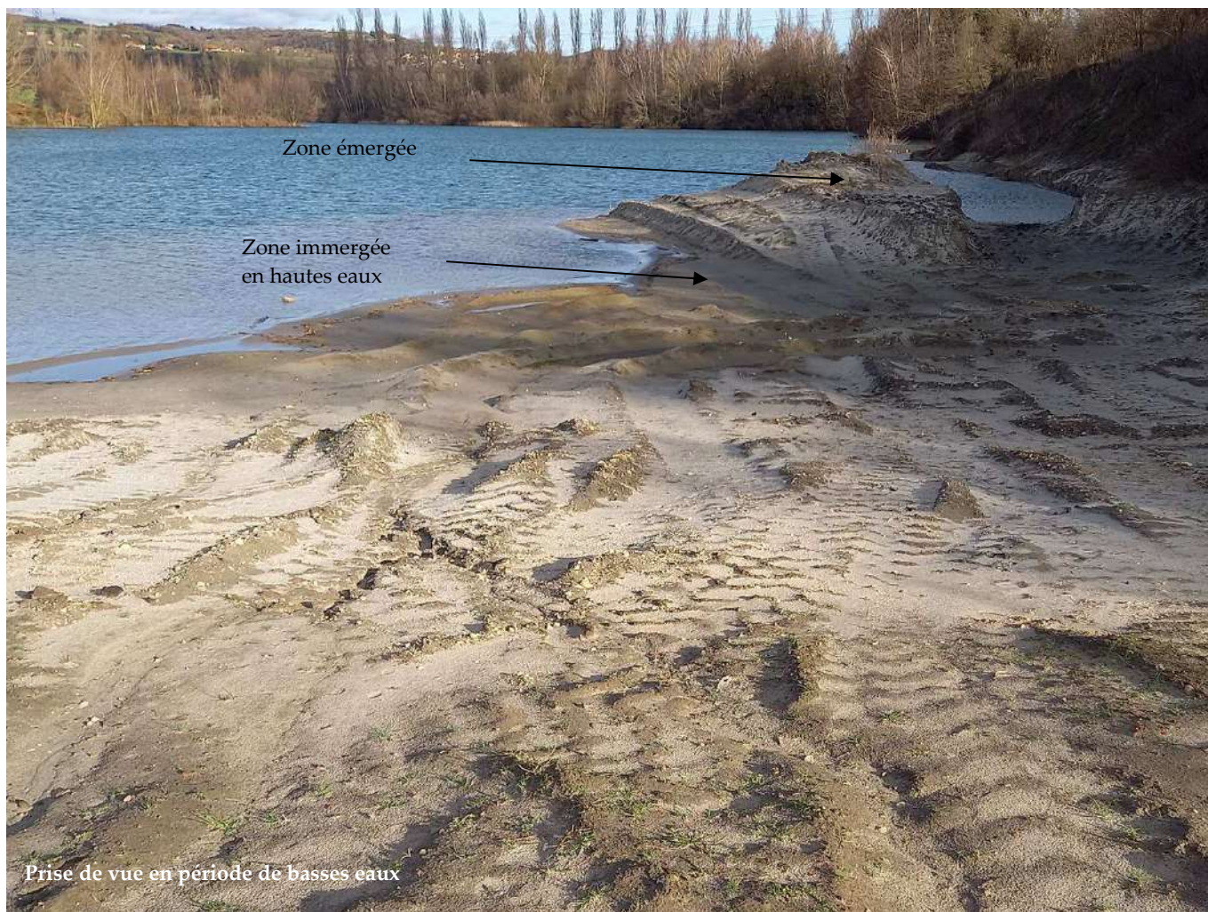
Photographie 50 : Aménagement soumis aux battements de nappe réalisé au droit de l'ancienne carrière
